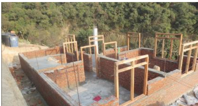
एक निर्माणाधिन घर
